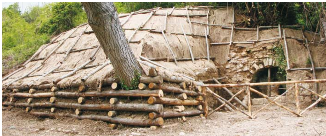
Intervento sul sentiero S3
